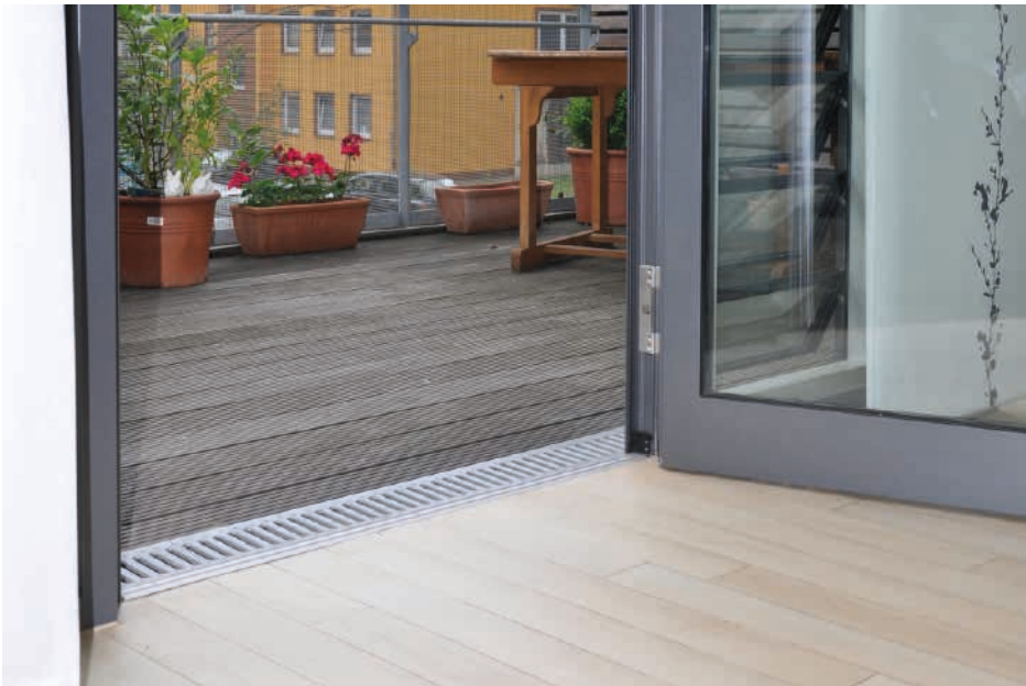
Schwellenlosen Übergang vom Aufenthaltsbereich auf die Terrasse
